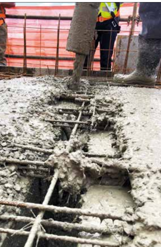
Lançamento de concreto reforçado com fibras
