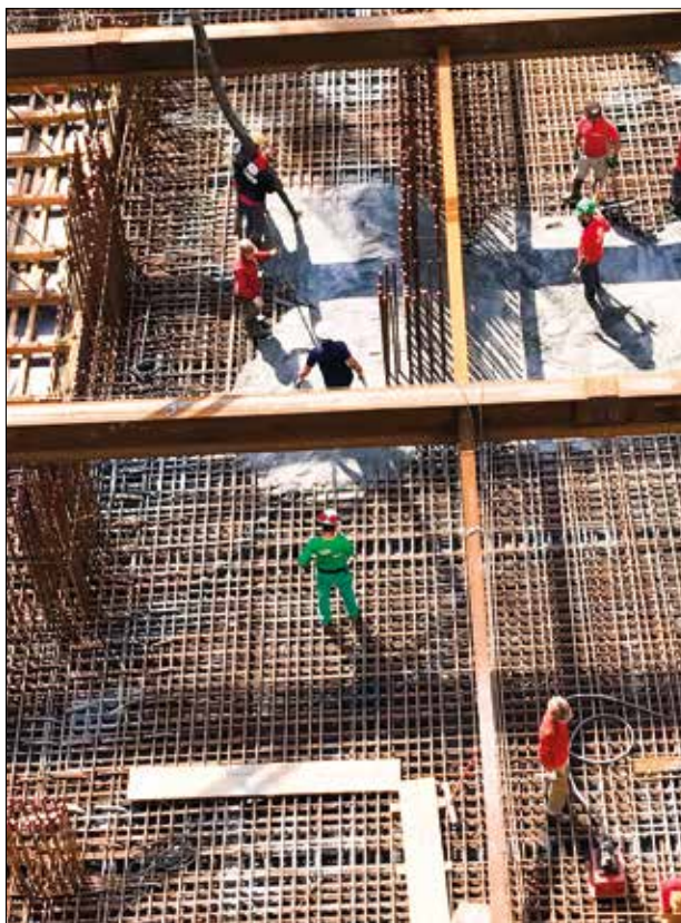
Vista superior de concretagem do bloco do Edifício Vitra: alta taxa de armadura exigiu uso do CAA
